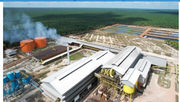
Gambar 7. Mill untuk mengolah TBS menjadi CPO dan PK
